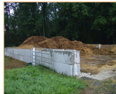
Estructura de almacenamiento de estiércol de pila seca
